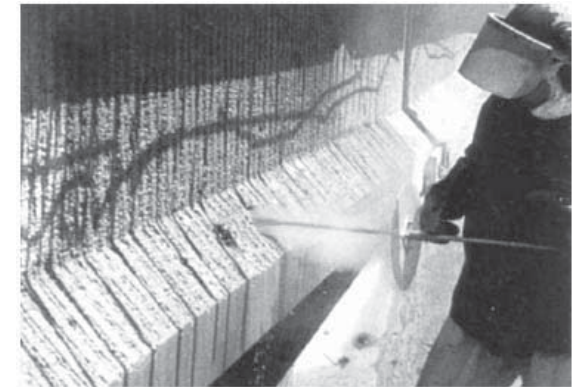
รูปที่ 5 การสกัดโดยวิธีใช้แรงดันน้ำ (ต่อ) (ที่มา: ACI 555)
