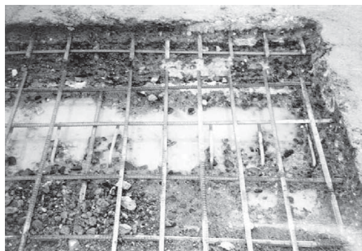
รูปที่ 7 สภาพของคอนกรีตหลังจากการสกัดด้วยวิธีใช้แรงดันน้ำ (ที่มา: ACI 555)
